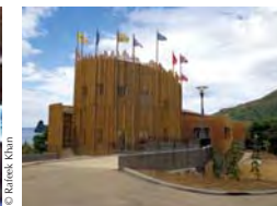
© Henry Scherer - Sciences du Net/hoort Bardage résille en Pin des Caraïbes - Mairie de Hienghène - Les Charpentiers du Nord - Nouvelles-Calédonie
